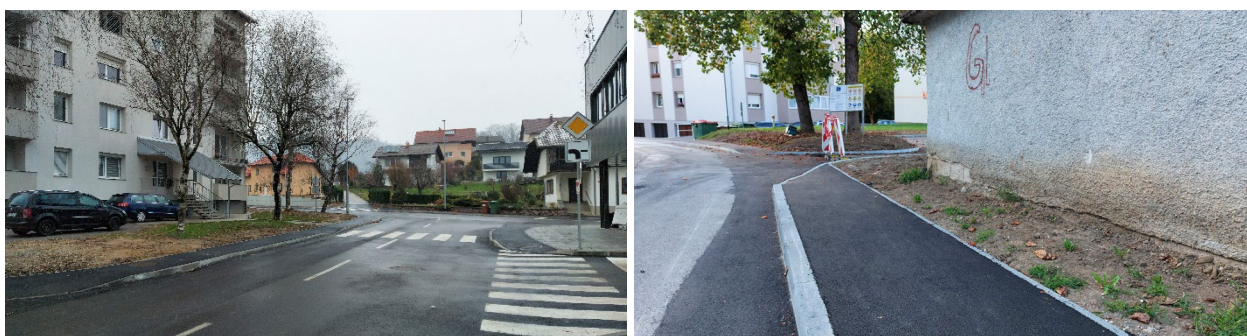
Slika 3: Poglabljeni robniški pločniki na novo urejenem cestnem odseku v središču Sevnice in poglabljen robnik pločnika ob rekonstrukciji uvoza na parkirišče v Naselju heroja Maroka.
