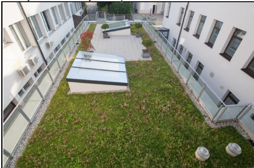
Obstoječa fizioterapevtska telovadnica – odstranitev strehe
