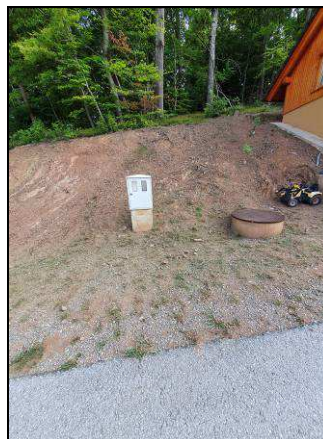
Električna omarica in vodomerni jašek
