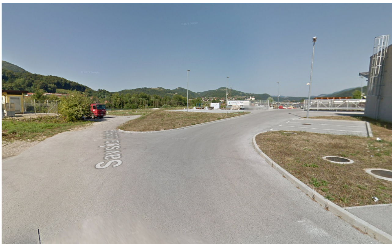
Slika 8: Pogled na območje nekdanjega Mercatorja v smeri severozahoda (ob Savi navzgor)
