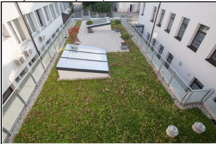
Obstoječa fizioterapevtska telovadnica – odstranitev strehe
