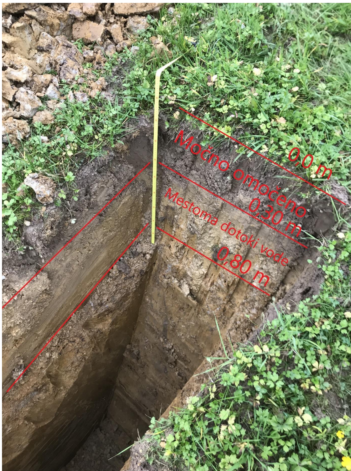
Slika 30: Dotoki vode na izkopu SI-1
