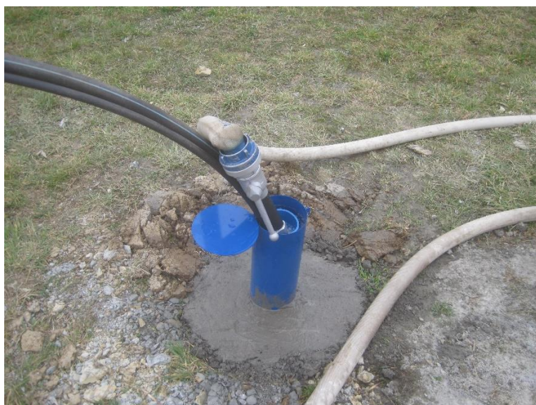
Slika 20: Aktivacija v vrtini DR-7P/20 z uporabo dvojnega airlifta
