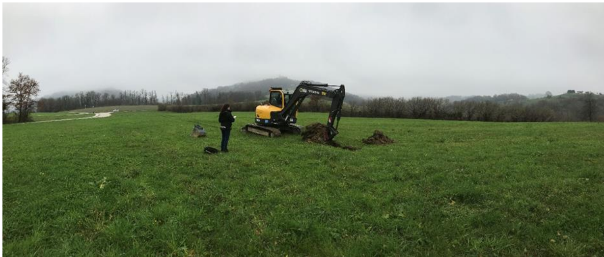
Slika 29: Lokacija izvedbe izkopa SI-1
