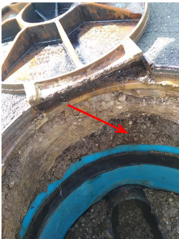
Slika 82 (leva slika): Najverjetnejši izvor usedlin v jašku
