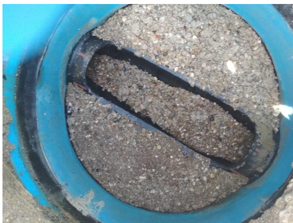
Slika 81 (desna slika): Notranjost jaška M 2-12 – gruščnate usedline
