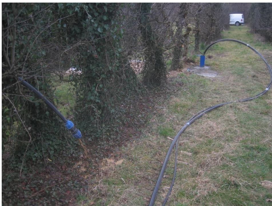
Slika 24: Aktivacija vrtine DR-8P/20 z dvojnim airliftom
