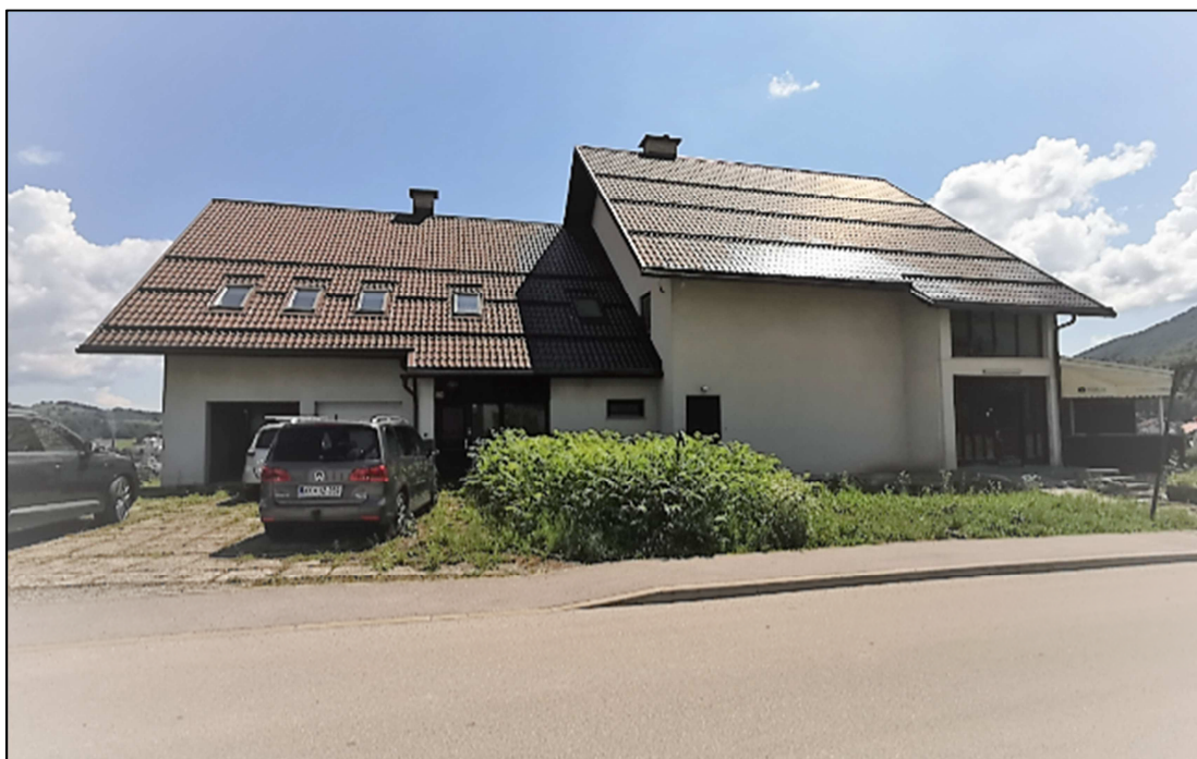
Slika 10: Pogled z Z smeri, s smeri lokalne ceste - glavna, vstopna fasad
