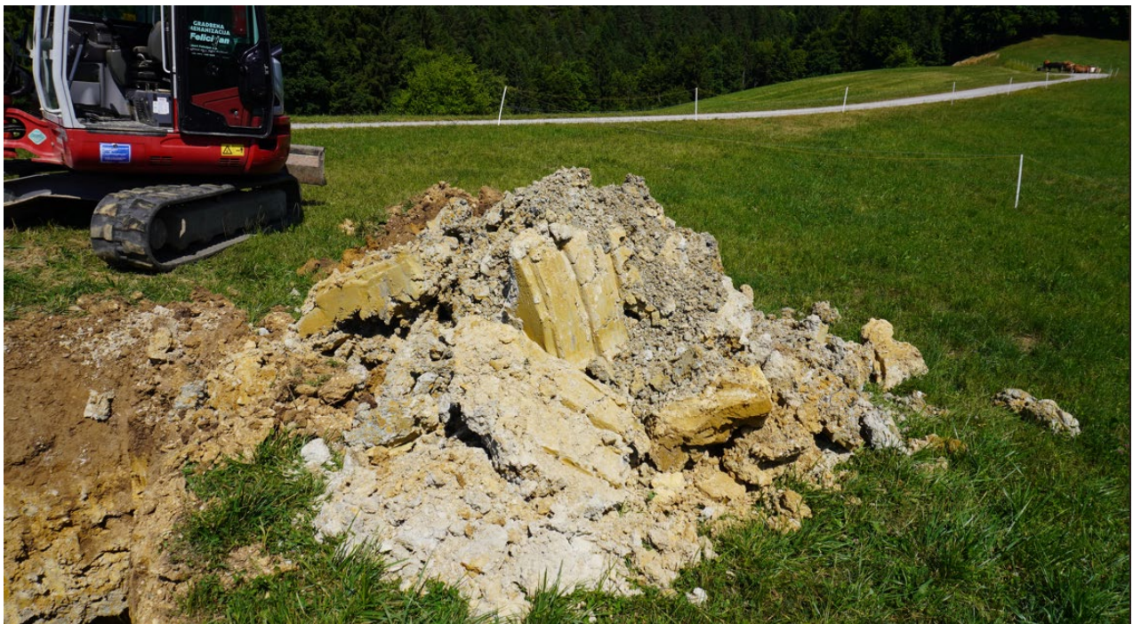
Slika 6: Izkopan material, razkop SR2.
