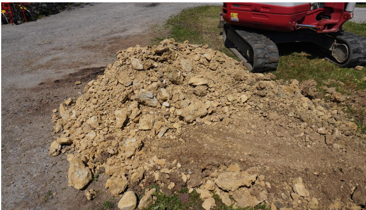
Slika 5: Izkopen material, razkop SR1.
