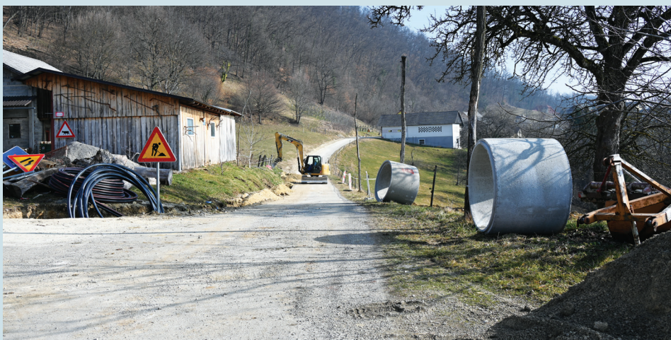
Gradnja vodovoda na Handiji
