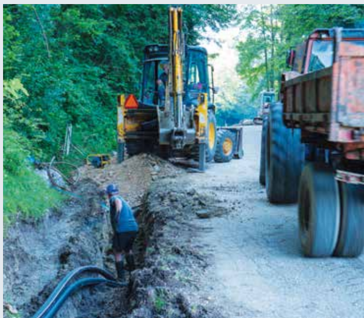
Izgradnja vodovoda na območju Cerja.
