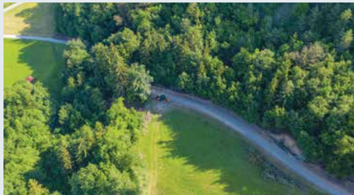
Izgradnja vodovoda na območju Cerja.
