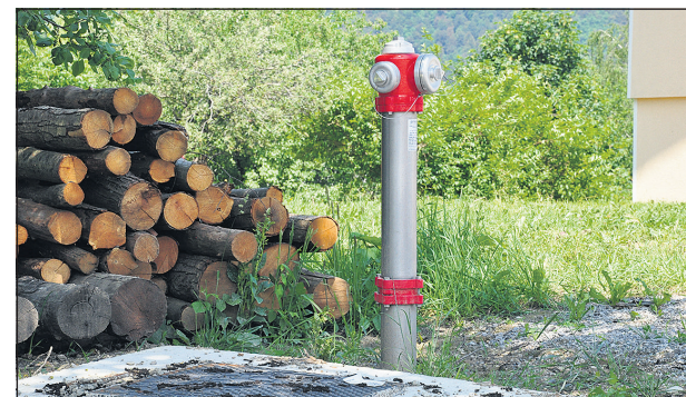
Postavitev novega hidranta
