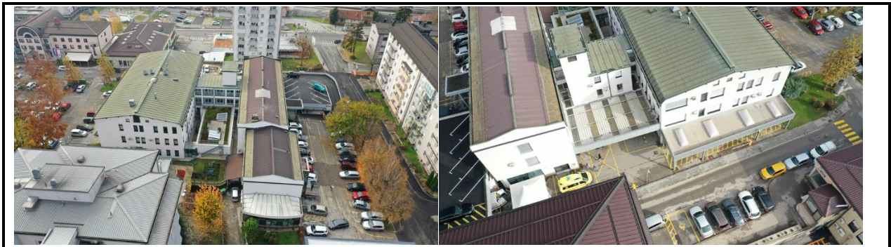
Pogled s severne strani območja SD OPPN
