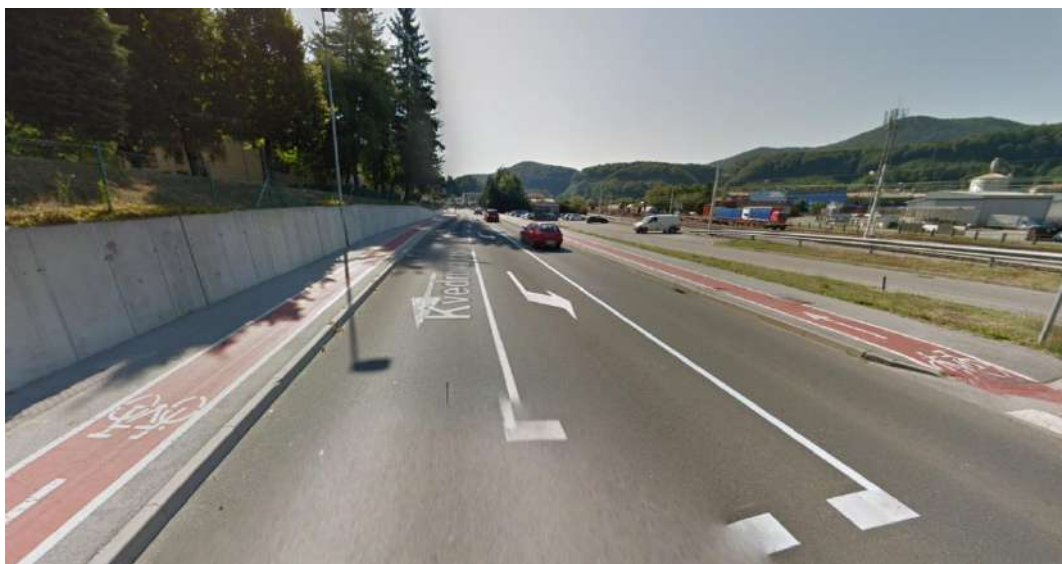
Slika 3.4: kolesarska pas ob regionalni cesti v Sevnici
