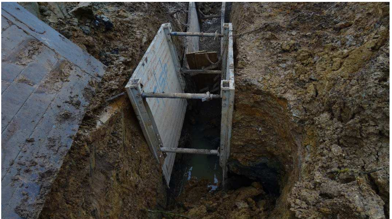
Slika 12: Izvedba spodnje drenaže.
