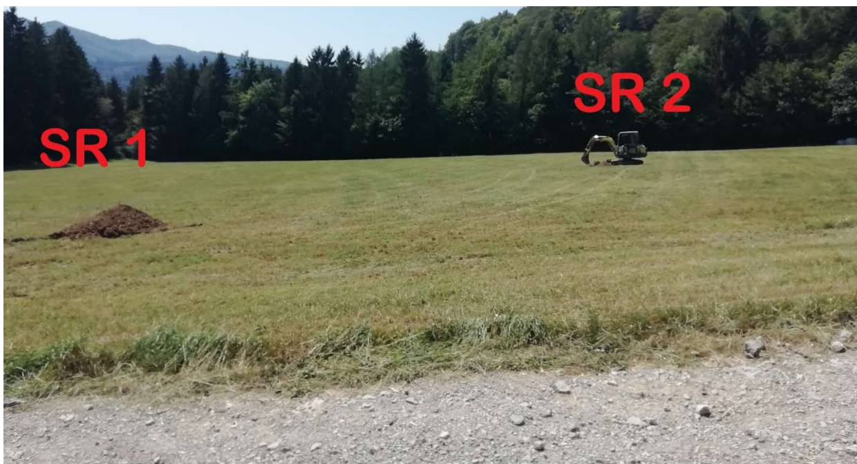
Slika 7: Območje novogradnje, z lokacijama izvedenih razkopov SR 1 in SR 2
