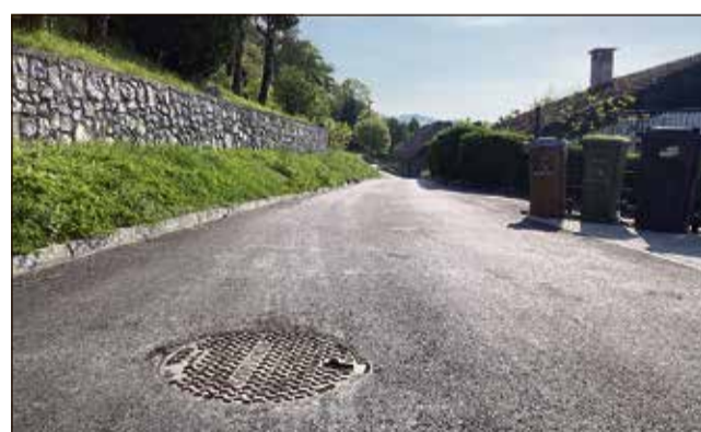
Umeščanje kanalizacijskega omrežja poteka po relacijah občinskih cest, ki se po zaključku gradbenih del povrnejo v prvotno stanje (foto: Občina Sevnica).
