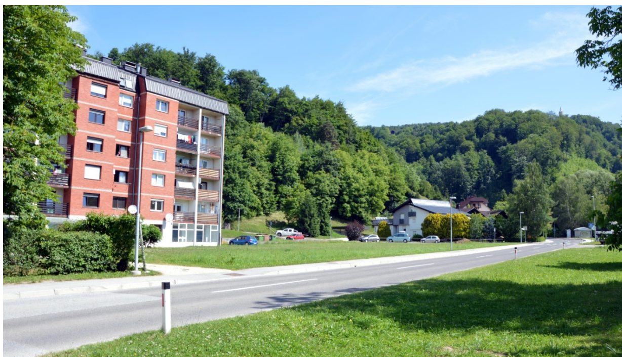
Slika 4: Pogled iz jugozahoda proti območju OPPN in obstoječemu bloku, vir: lasten arhiv
