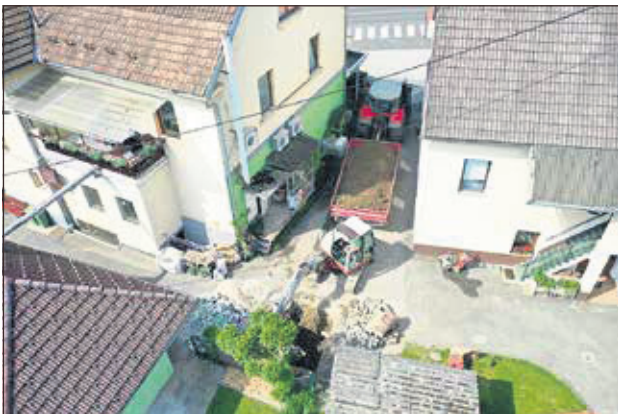
Začetek gradnje odseka kanalizacije na Kvedrovi cesti ...
