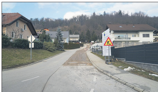
Zaključena obnova mešanega kanalizacijskega sistema na Bohorski ulici v naselju Šmarje
