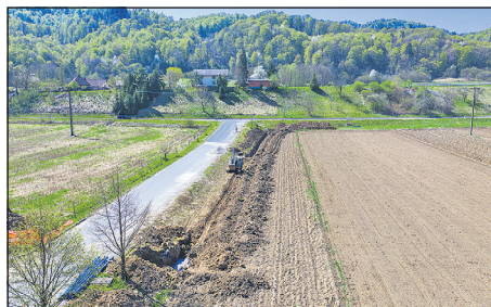
Polaganje vodovodnih cevi na Logu
