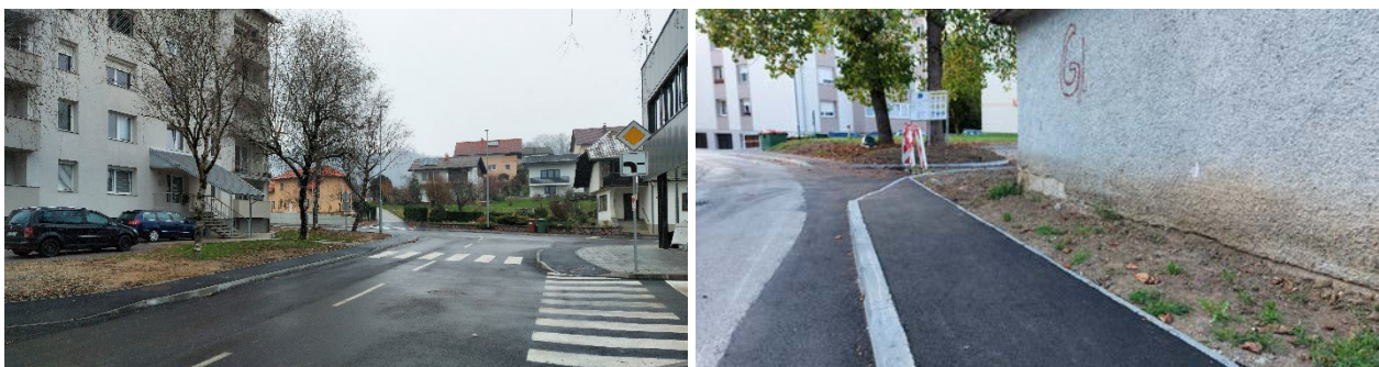
Slika 3: Poglabljeni robniki pločnikov na novo urejenem cestnem odseku v središču Sevnice in poglabljen robnik pločnika ob rekonstrukciji uvoza na parkirišče v Naselju heroja Maroka.
