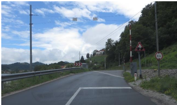
Železniški prehod in ceste v Logu
