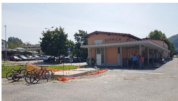
ŽP Sevnica, parkirišče za kolesa in za avtomobile v ozadju
