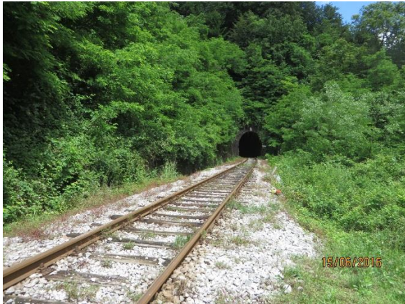
Predor železnice pred postajo Jelovec
