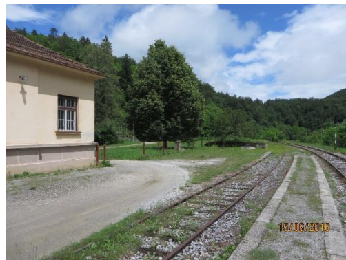
Odstavni tir železniške postaje Jelovec
